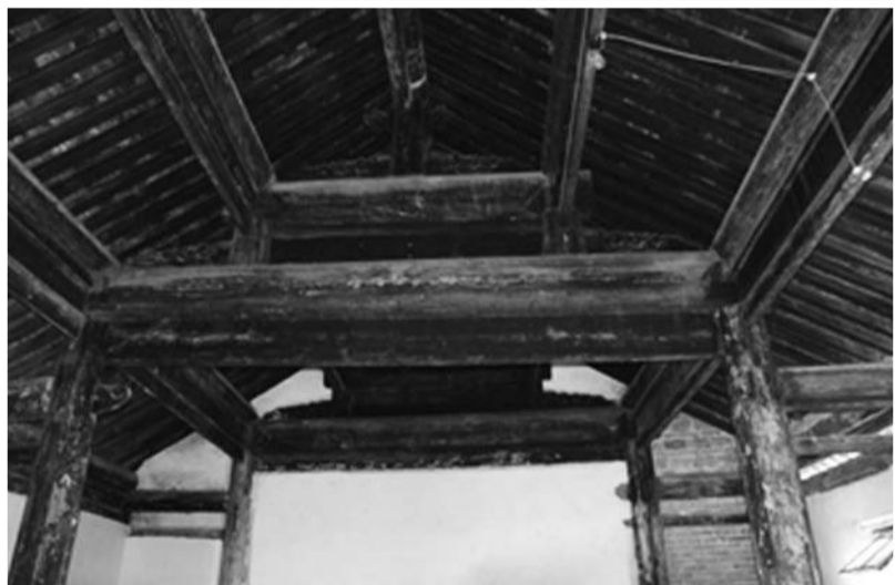
进士第房内的梁架结构。
