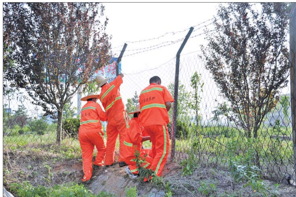
▲高速公路的养护工人正在修补防护网。
