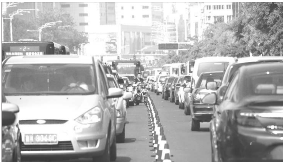
因为封闭施工,南大街东段北半幅隔离出两个车道,道路拥挤,车辆行驶缓慢。本报记者 李泊静 摄
