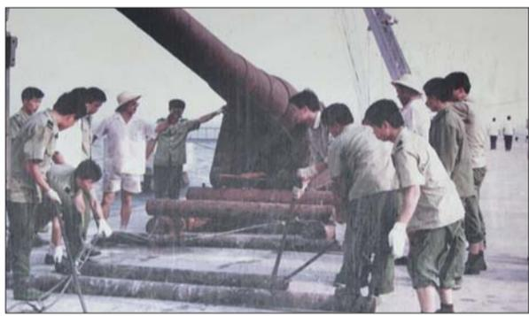
岛上没有大型吊运机械,就采用传统的圆木滚动搬运法,花了40多天将“济远”舰主炮运到提督署。(资料片)
