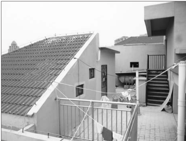
万象城9区3号楼楼顶新建的房屋已经精装修,正准备出租。本报记者 王伟平 摄
