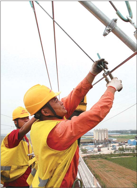
青荣城际铁路建设者铺设接触网。通讯员 房保平 摄
