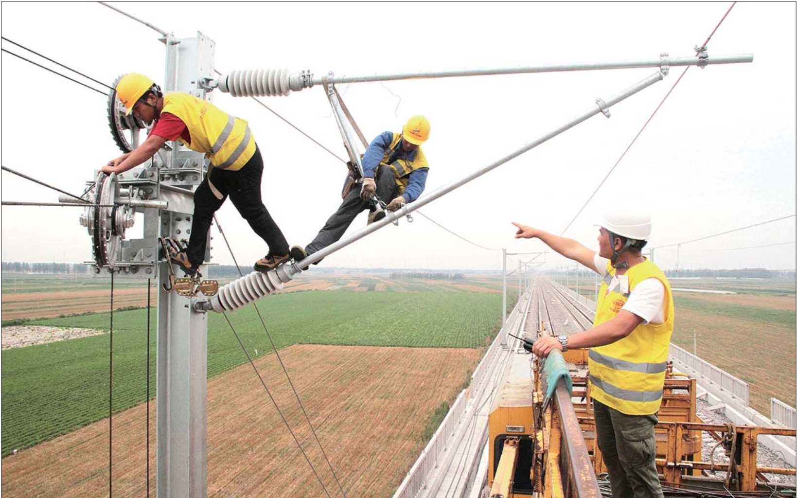
青荣城际铁路建设者铺设接触网。通讯员 房保平 摄
