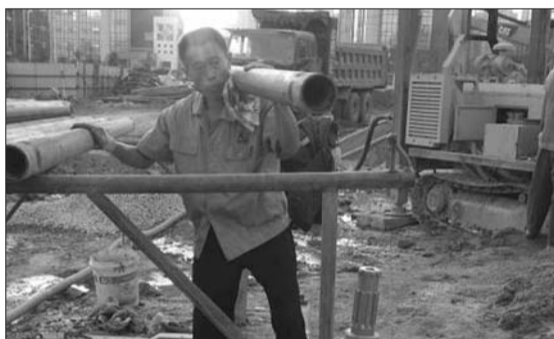
工人们正在安装钻杆。 本报记者 李清 摄
