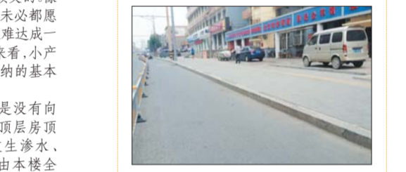
路沿石不能随意拆除。 本报见习记者 张玉岩 摄
