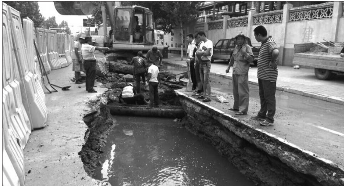
市政施工人员对塌方处开挖,以确定塌方原因。本报记者 公素云 摄
