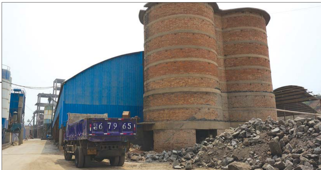
总部在山东的兴丰行投资担保公司确定的投资企业是洛阳龙佳建材有限公司,该公司厂房是一片简易工棚。(资料片)
