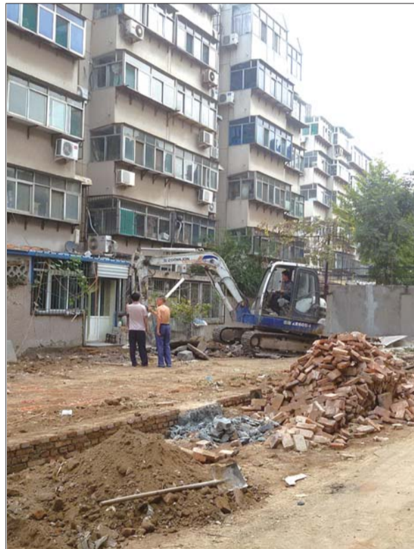
施工人员正在搭建新车棚。见习记者 于悦 摄
