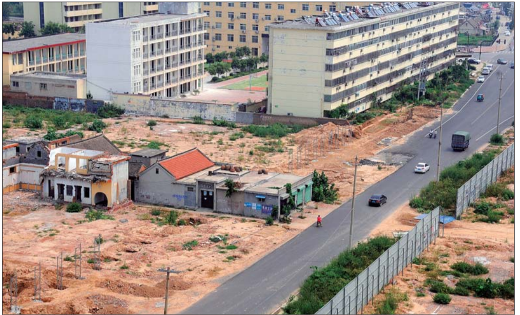
俯视中山路,未拆迁的房屋造成马路突然变窄。
