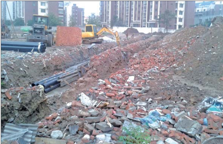
▲金色港湾小区北边即将建新楼房的空地,正在进行地下施工。
