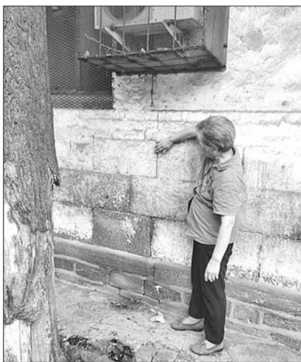
于老太说，靠树一侧的房子的外墙已经被树根撑出了裂缝。 本报记者 柳斌 摄
