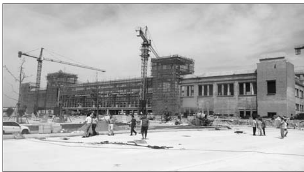
青荣城际铁路烟台南站站房主体已经完工。 本报记者 钟建军 摄
