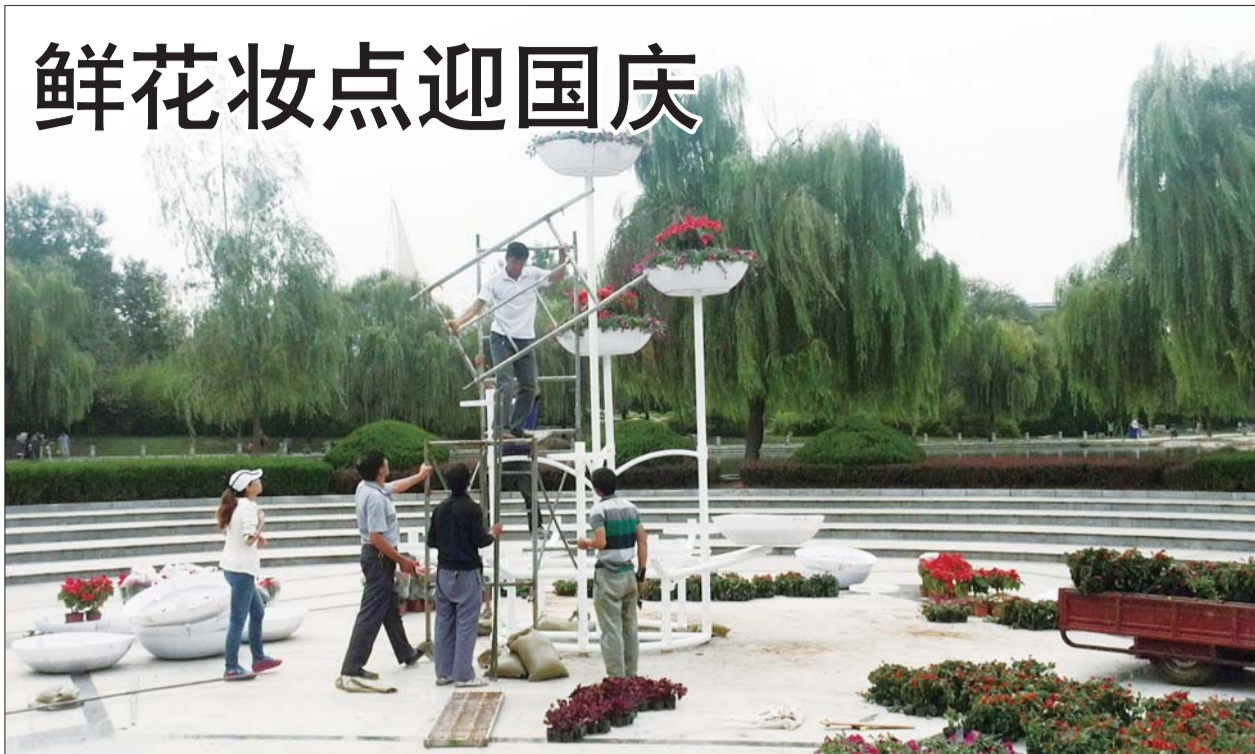
11日,邹平县园林处工作人员正在人工湖下沉式广场安装花架。国庆节期间,邹平县将继续按照节俭、喜庆、美观的原则,在高速公路出口、政府北广场、人工湖、财税大厦路口等城区主要节点安装大型组合花架。 本报通讯员 邓长征 摄影报道
