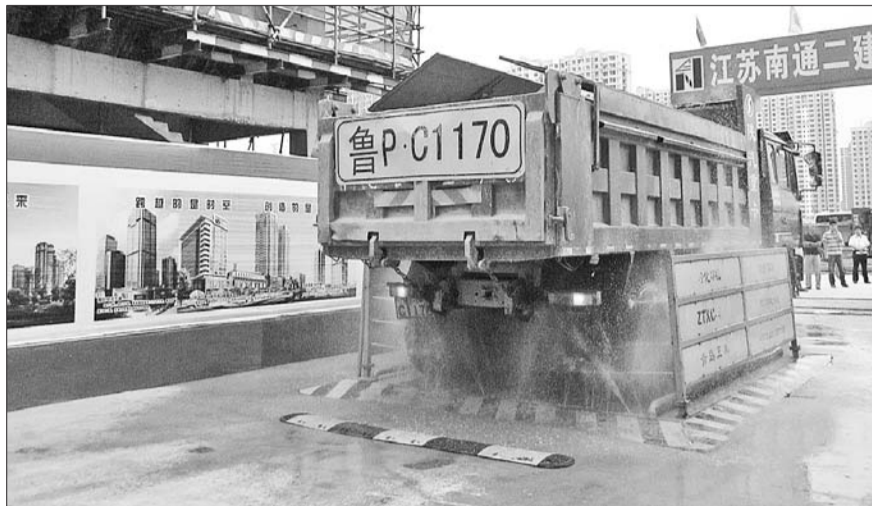
在聊城一家工地出入口,配备了高压冲洗设备,为渣土车洗澡。本报记者 孟敏 摄
