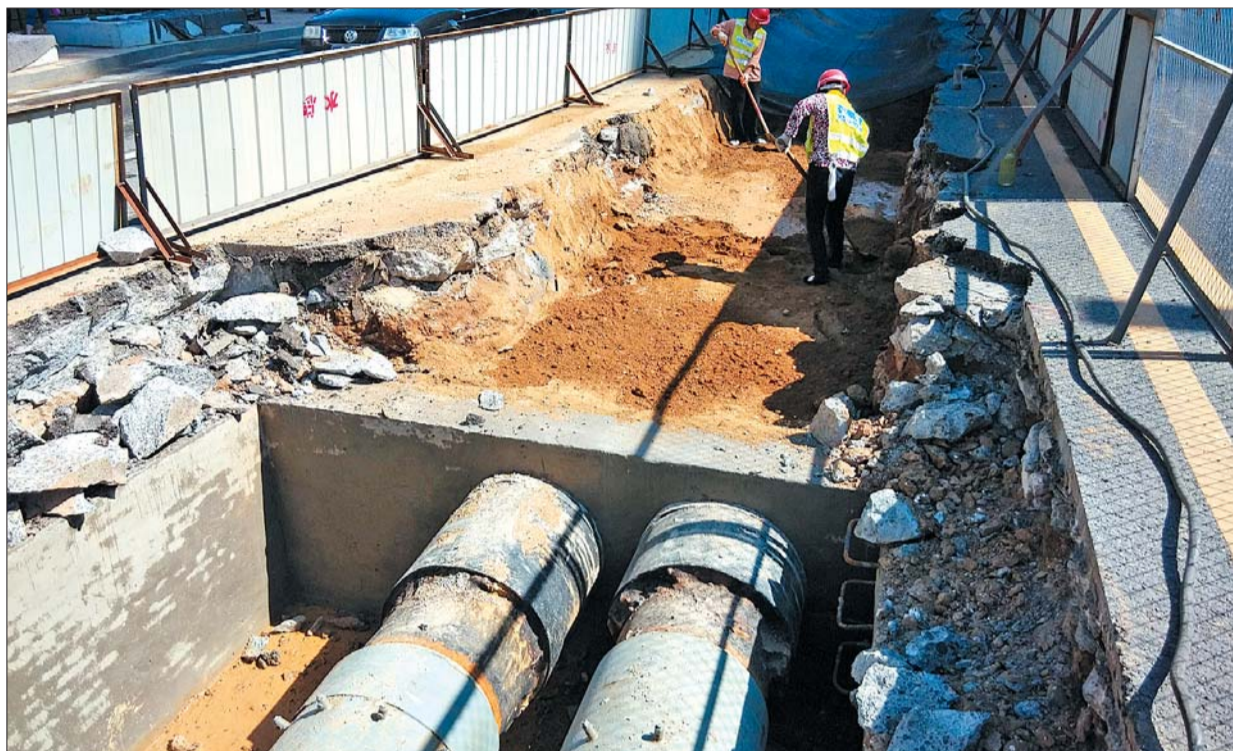
济南热力公司正在进行“汽改水”工程,将余出部分热源尽量满足更多小区的需求。 本报记者 蒋龙龙 摄
