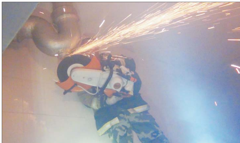
消防员将三楼的管道进行破拆。
