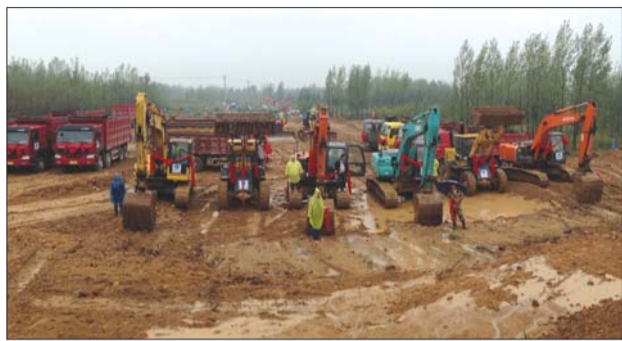
104国道改建工程16日开工。本报记者 王世腾 摄
