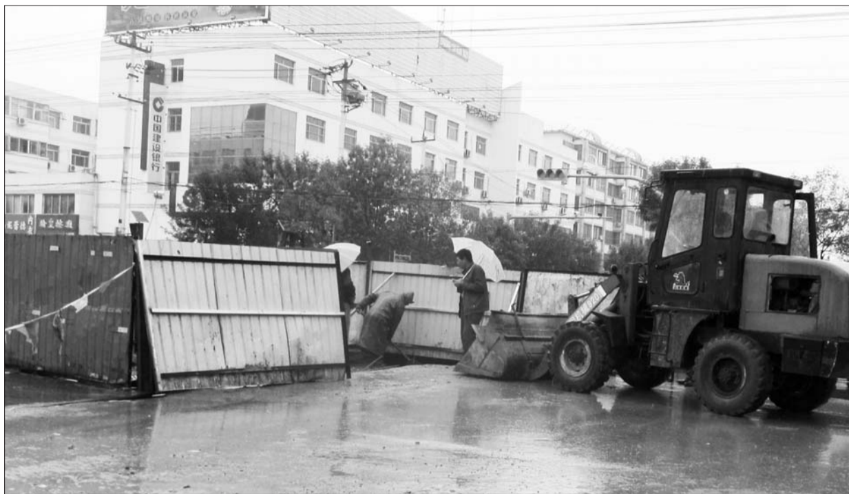
9月17日,在青年路上的供暖管道改造施工现场,工作人员冒雨对坑道进行回填,防止降雨诱发坍塌。本报记者 马志勇 摄
