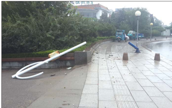
监控探头立杆被撞断。本报见习记者 刘真 摄
