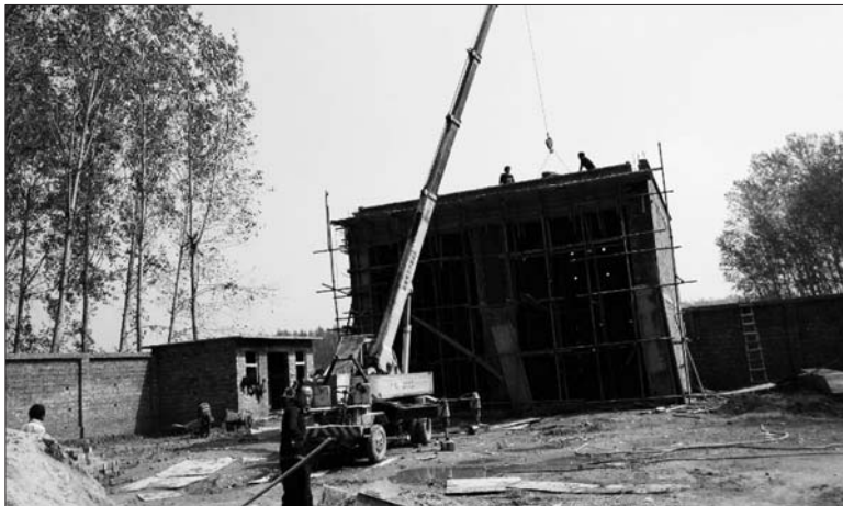
在阳谷县金斗营乡紧靠着金堤河的树林里,一处垃圾站中转站正在建设。
