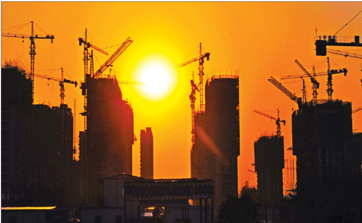
阳光照耀下的新建高楼
