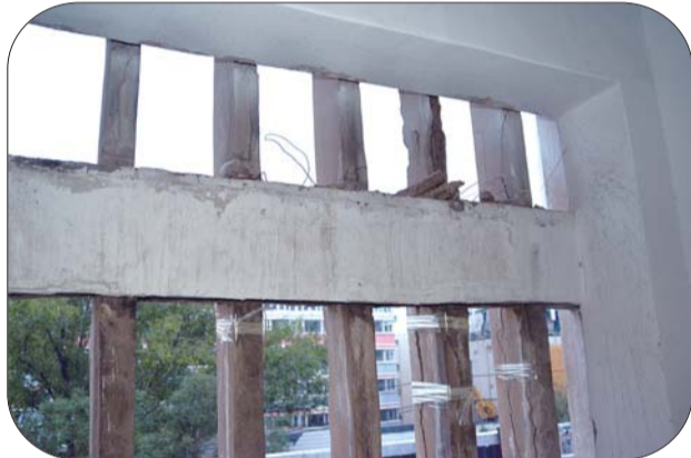
▲柱子上的裂缝用胶带粘了起来。
