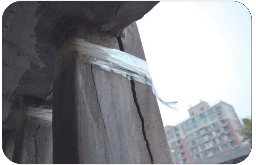
▲柱子上的裂缝用胶带粘了起来。
