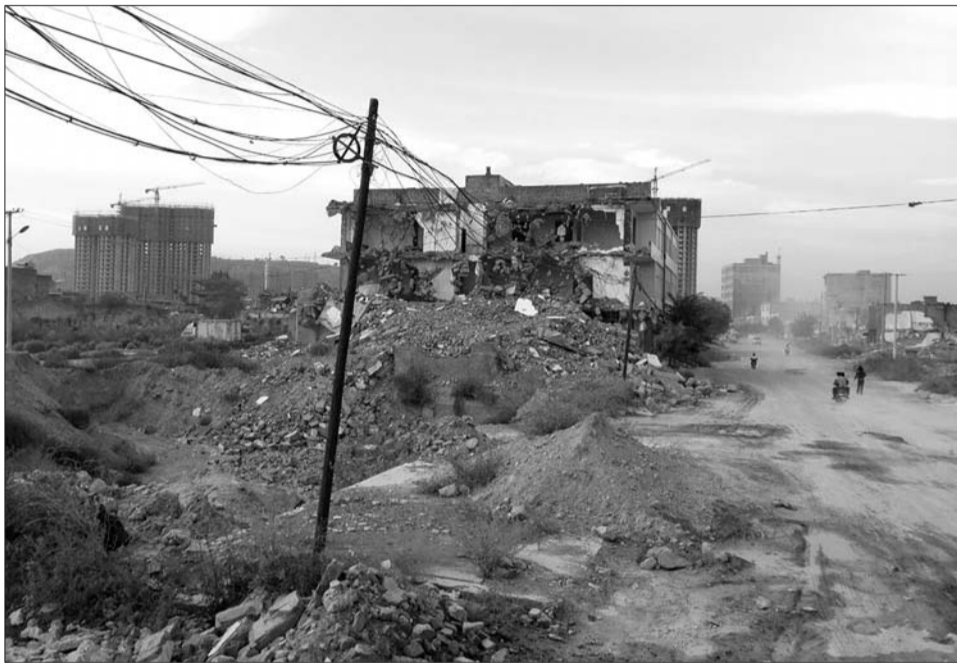
拆迁中的吕梁方山大武镇,原本这里要建新区,随着前市长丁雪峰被查,很多工程陷于停滞。
