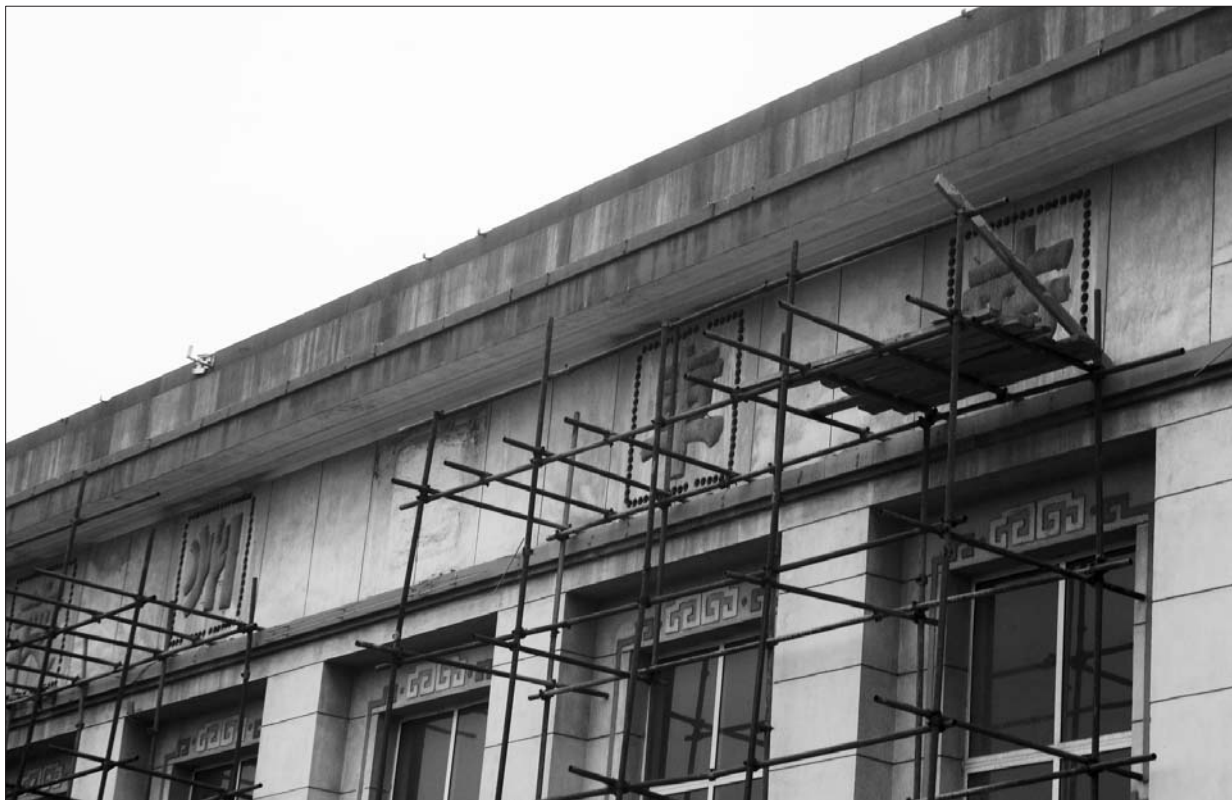
原“德州车站”四个字已完成周边打孔,准备拆下保留。 本报记者 马志勇 摄
