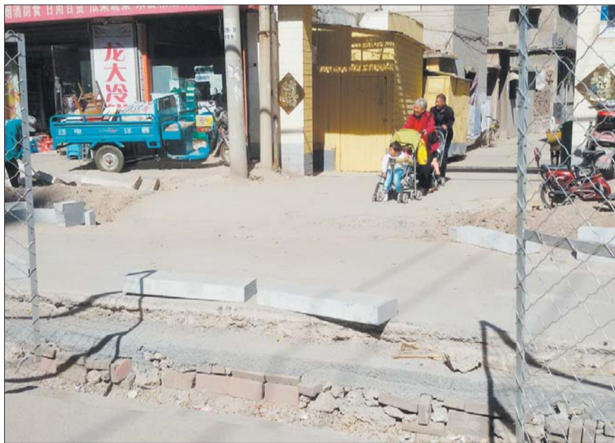
村入口处的深沟没有围栏遮挡。见习记者 于悦 摄
