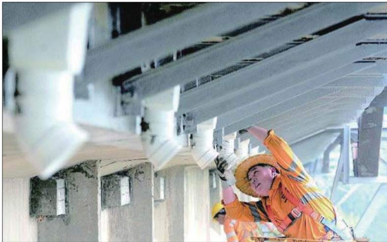
工人正在给大桥更换排水管
