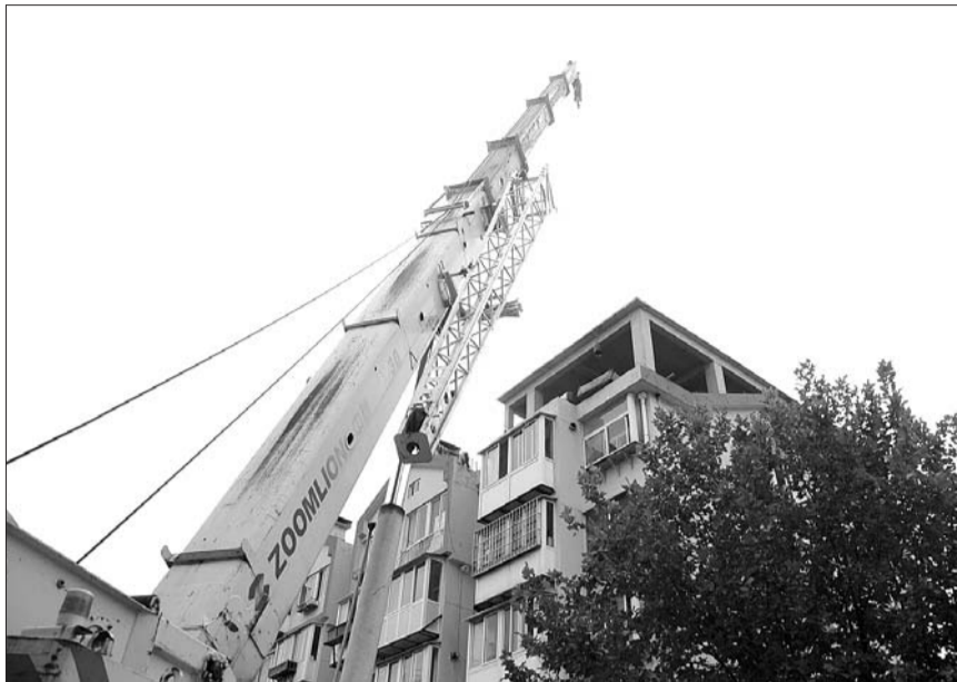
正在加盖的顶层楼房已完成水泥框架。本报记者 李泊静 摄
