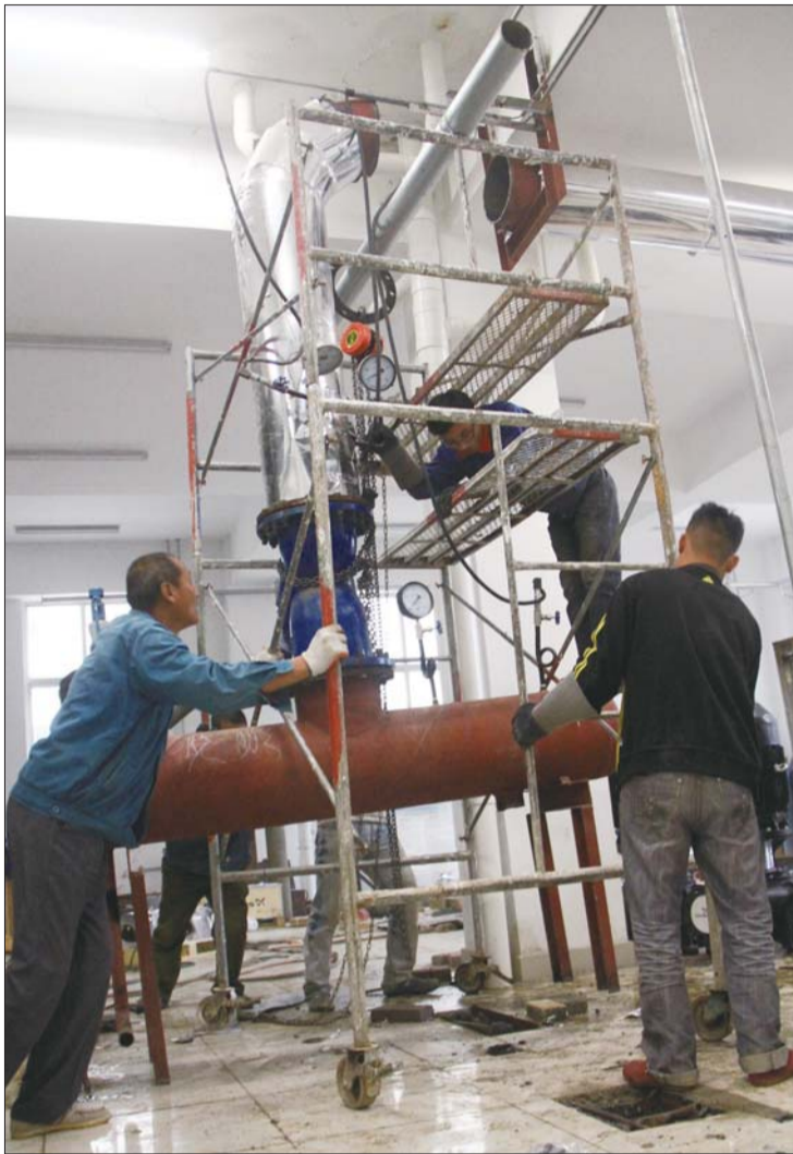
10月20日,德州学院东区宿舍楼院内,施工人员在新增的供热站内拆装供暖管道。 本报记者 王小会 摄
