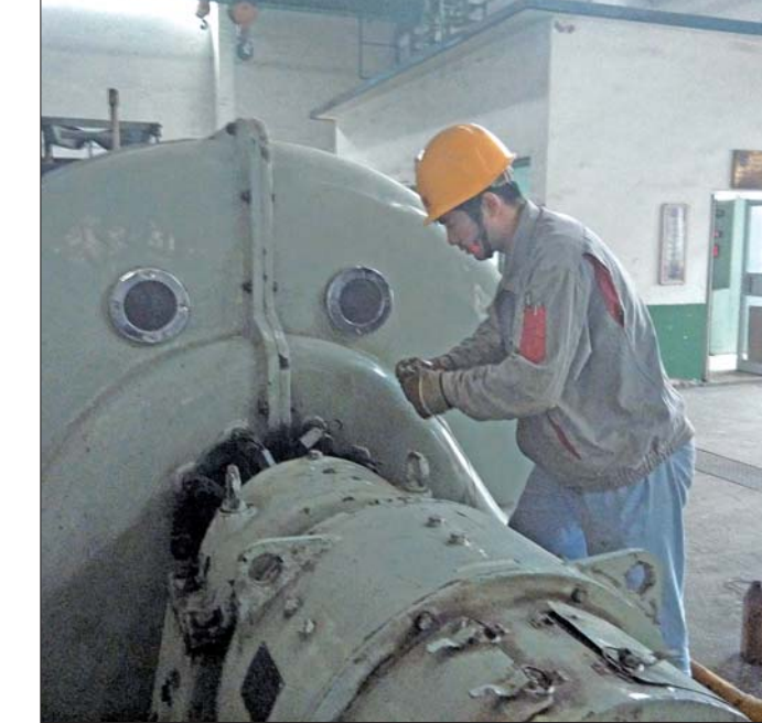
明湖热电厂,工作人员正在检修设备。 本报记者 蒋龙龙 摄
