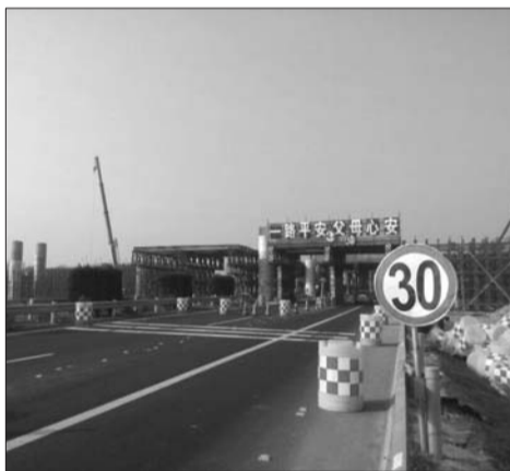
济宁互通立交跨日兰高速施工现场。
