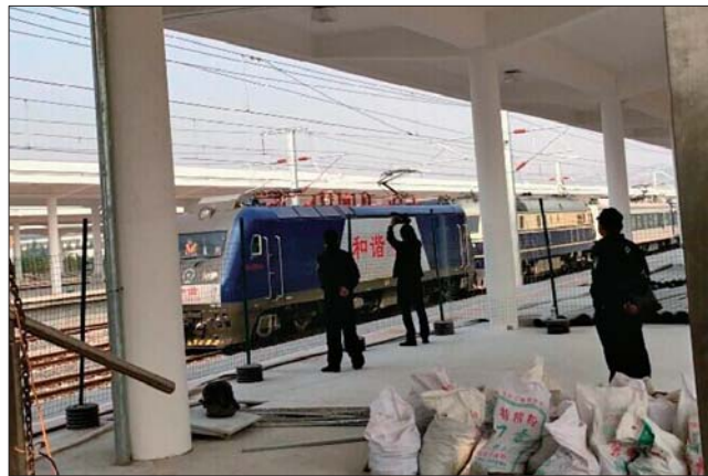
22日上午,城铁测试车通过威海站。记者 王帅 摄
