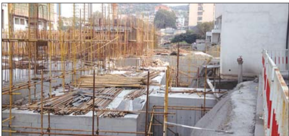
知山雅筑3号楼前停车库地上部分正在施工。
