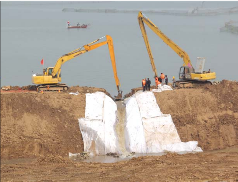
八里湾船闸破堤施工。 本报通讯员 摄
