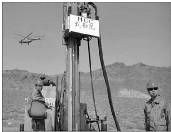
中方技术人员在阿富汗埃娜克铜矿勘测。(资料片)
