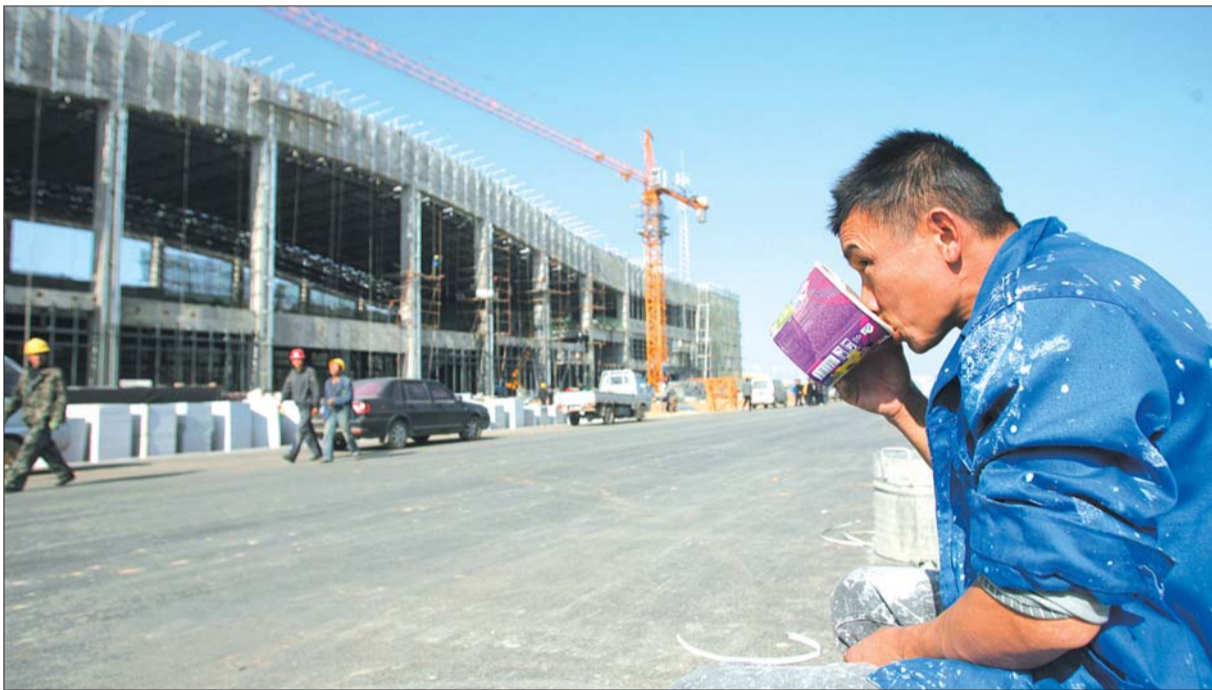
28日,荣成站外,一名工人正在吃泡面。目前荣成站正在紧张施工中。本报记者 赵金阳 摄
