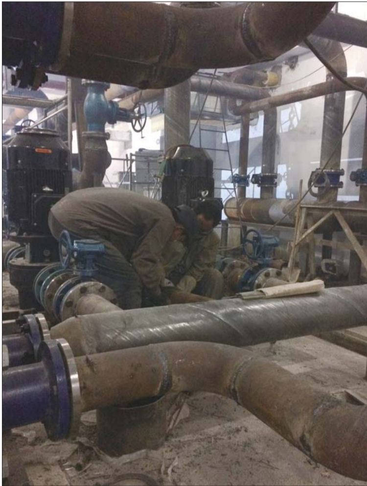
10月29日,第一年供暖的东海巴黎城小区,工人正在抓紧安装换热站,待调试设备后便可达到正常供暖要求。 贺莹莹 摄
