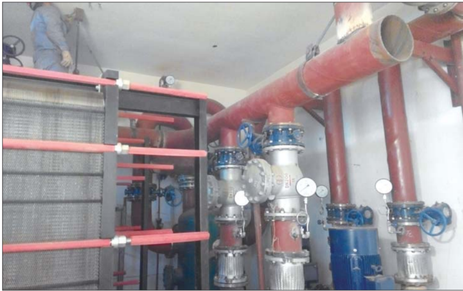
长安欣苑小区换热站今年才建成,仍在安装设备。本报记者 王皇 摄
