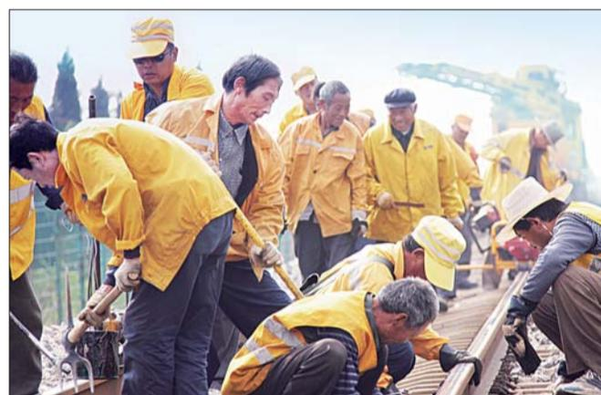
根据今年铁路总公司和路局统一部署安排,为期30天的京沪线集中施工将于11月19日结束,216个天窗点内进行道岔钢轨更换、线路道岔破底清筛、无缝线路应力放散、线路道岔大机捣固等8个项目施工。图为该段泰山线路车间在京沪上行线大汶口至大河区间组织线路大机清筛施工。韩振军 摄
