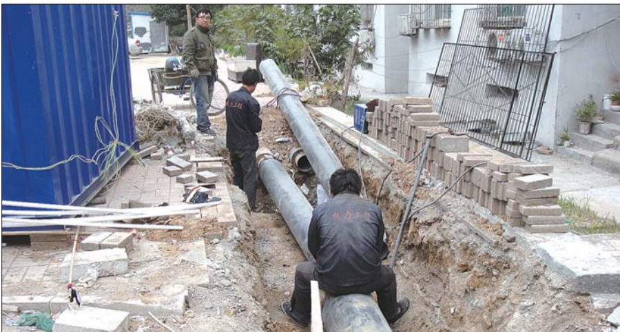
友谊苑供暖施工现场。通讯员 闫绪森 摄
