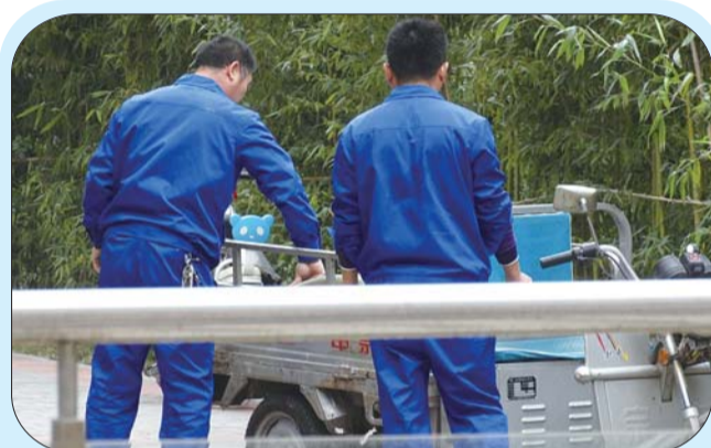
供暖季即将到来,现代逸城社区德胜物业工程部工作人员提前为大家进行供暖设备的调试与检查,为社区居民家庭度过一个温暖的冬天做好准备工作。(杜鹃)
