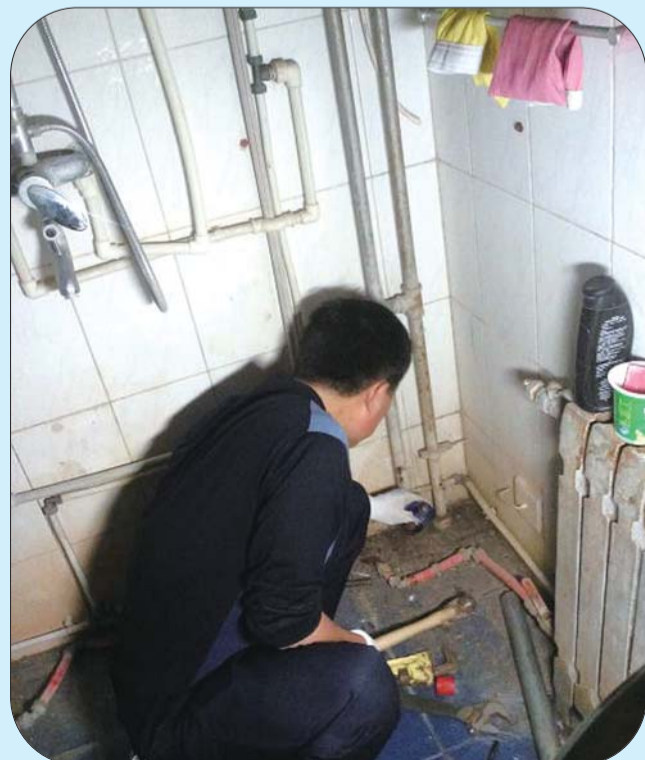
采暖季即将开始,十里河社区南区物业工作人员积极开始备战,检修小区内管道,及时更换老化管道。居民家中暖气管道如果有问题,请到物业部门登记,以便及时维修。(张彬)
