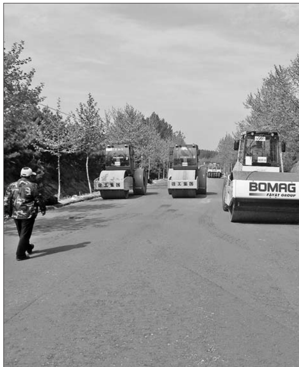
▲2012年春天,但李线路面基层施工,这条公路的改造升级有利于荣成俚岛与西部各镇以及文登的区域联系。
