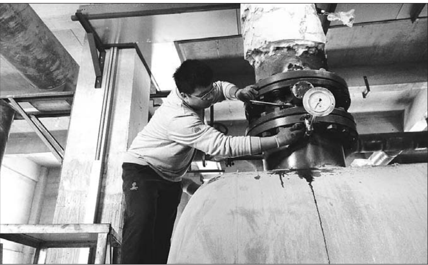
13日, 滨州滨城区西城供热站工作人员在对换热器进行检修。本报见习记者 杜雅楠 摄
