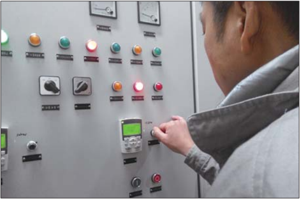
通过变频器上的旋钮就能调节换热设备,不再需要转动轮盘。
