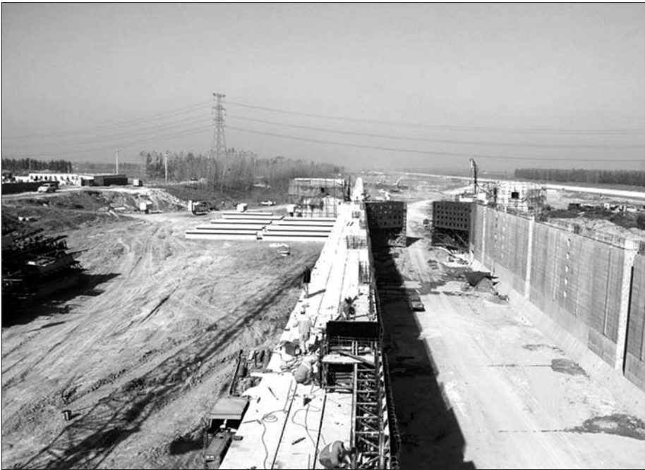
长沟船闸主体工程已经完成。本报记者 庄子帆 摄
