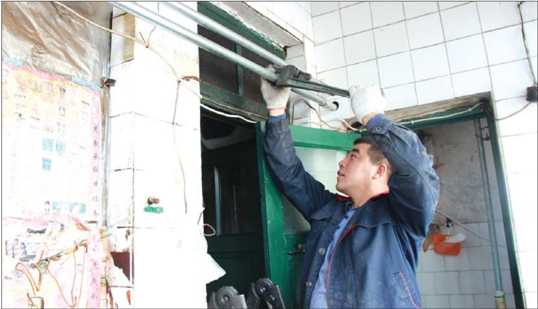
工作人员正在安装室内暖气管道。本报记者 孟杰 摄
