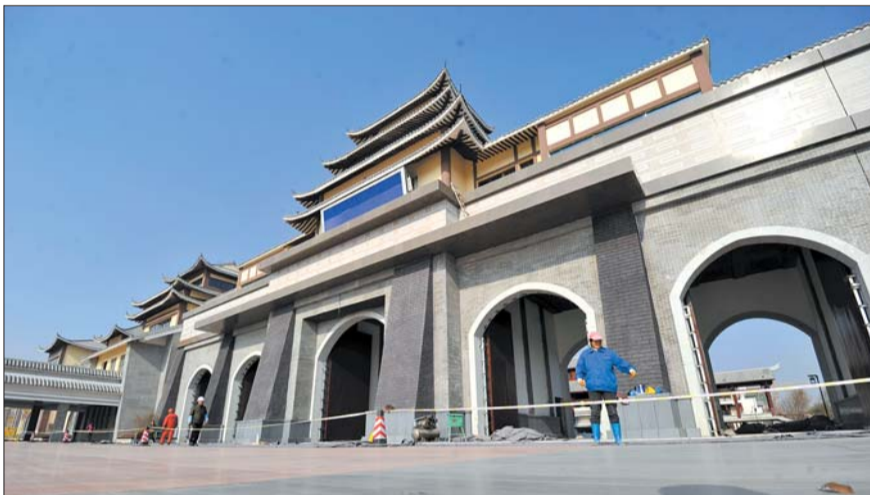
18日,位于济南槐荫区吴家堡的非物质文化遗产博览园内,宏伟的仿古大门颇具规模。据工作人员介绍,目前,园区内的16个主题馆土建工程已经完成95%,园区道路、湖泊、地形绿化工程也基本完成,有望2015年春节试运营。
