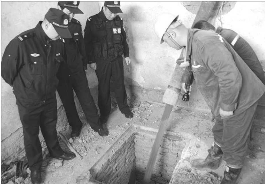
在废弃厂区内,民警发现了盗挖的井口。 警方供图
